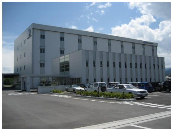
辰野・重合トナー工場竣工（2007年）
